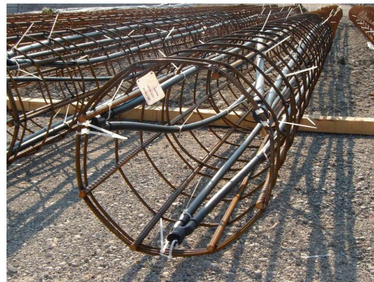
300 energetskih pilota 20m dubine bivalentni režim
